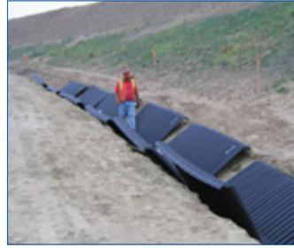
As seções SmartDitch, fabricadas em extensões de 8' a 10', estão prontas para serem unidas no fosso raso ou acima do solo, e posicionadas.
