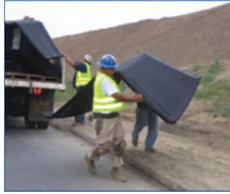
O SmartDitch é leve o suficiente para ser transportado manualmente até o fosso, permitindo o fácil transporte para áreas em que o acesso de veículos é limitado.
