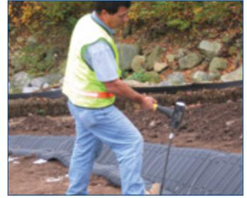
O sistema de ancoragem SmartDitch é instalado rapidamente para fixar o sistema no solo.
