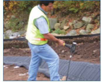
Il sistema di fissaggio SmartDitch si installa rapidamente e blocca il sistema al terreno.
