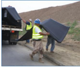
SmartDitch è abbastanza leggero da poter essere trasportato a mano sul fossato, e spostato facilmente in aree difficilmente accessibili con i veicoli.
