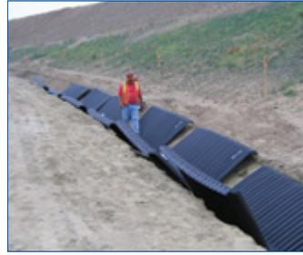
Le sezioni di SmartDitch, realizzate in lunghezze da 2,4 - 3 m, sono pronte per essere collegate in fossi poco profondi o in superficie e collocate in sede.
