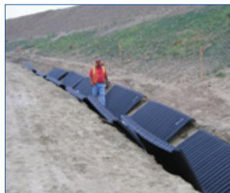
Die einzelnen SmartDitch-Abschnitte sind in Längen von 8 oder 10 Fuß erhältlich und müssen nur noch im flachen Graben selbst oder daneben zusammengefügt und dann eingesetzt werden.
