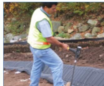
Mit der SmartDitch-Verankerung wird das System schnell und sicher im Untergrund fixiert.
