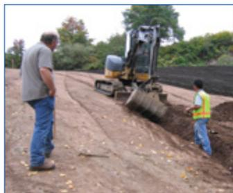
Ein leichter Baggerlader reicht zum Ausheben des niedrigen Grabens für den Einbau des SmartDitch-Systems aus.
