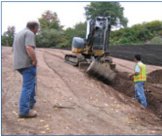
Une pelle rétro de faible capacité est tout ce qui est nécessaire pour creuser la tranchée peu profonde pour préparer l'installation de SmartDitch.
