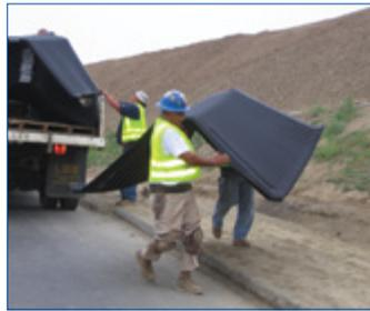
SmartDitch est suffisamment léger pour pouvoir être transporté manuellement dans la tranchée, et il peut être facilement transporté dans des lieux où l'accès des véhicules est limité.
