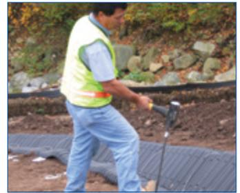
Le système d'ancrage SmartDitch s'installe rapidement et fixe solidement le système dans le sol.
