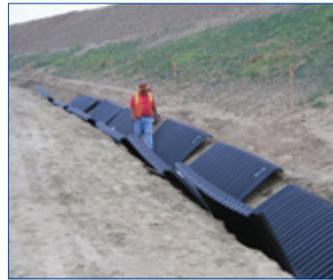
Les sections SmartDitch, de longueur 8' - 10', sont faciles à raccorder dans la tranchée peu profonde ou en surface, et à mettre en place.
