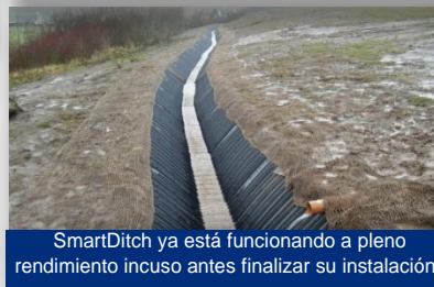
El equipo de construcción instaló 1736 m de SmartDitch en 8 semanas (incl. retrasos por causas climatológicas).
