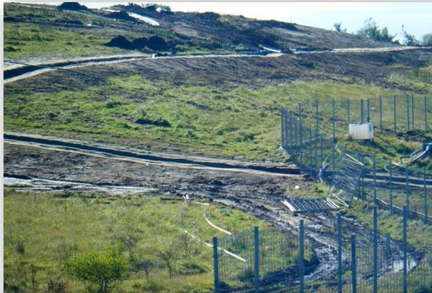
Se emplearon más de 1736m de SmartDitch en este vertedero en el Reino Unido para corregir los problemas de escorrentías y erosión causados por el desbordamiento de agua de la cima.
