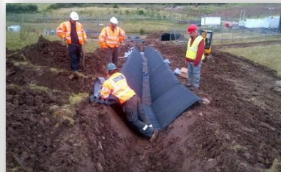
El equipo de construcción instaló 1736 m de SmartDitch en 8 semanas (incl. retrasos por causas climatológicas).
