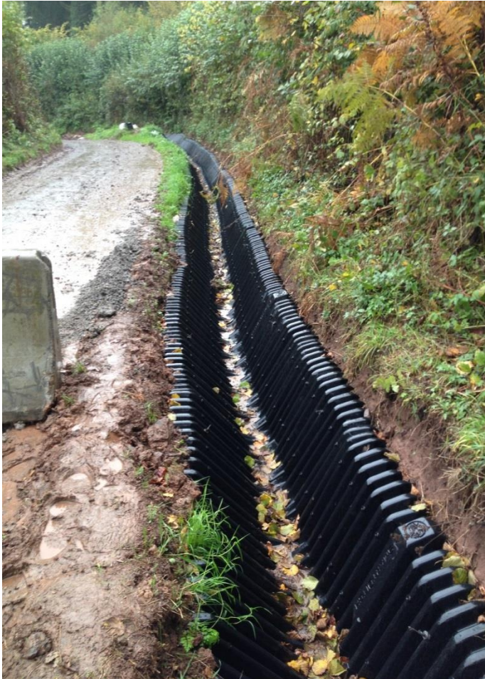
SmartDitch instalado en el lateral del camino
