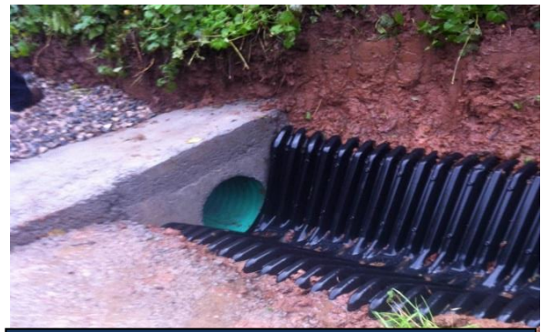
El SmartDitch se sella contra la superficie de hormigón
