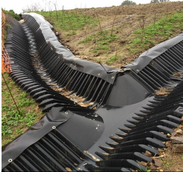
Cruce y protección de bordes del SmartDitch
