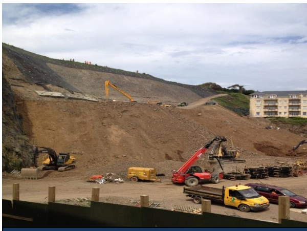
Vista desde la parte inferior de la cantera durante la construcción
