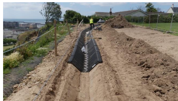
Instalación de SmartDitch en la cima del terraplén para captar la escorrentía
